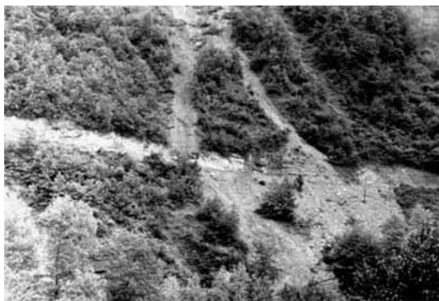
Slika 1. Oštećenja na nagnutom terenu prilikom izgradnje šumskih cesta
